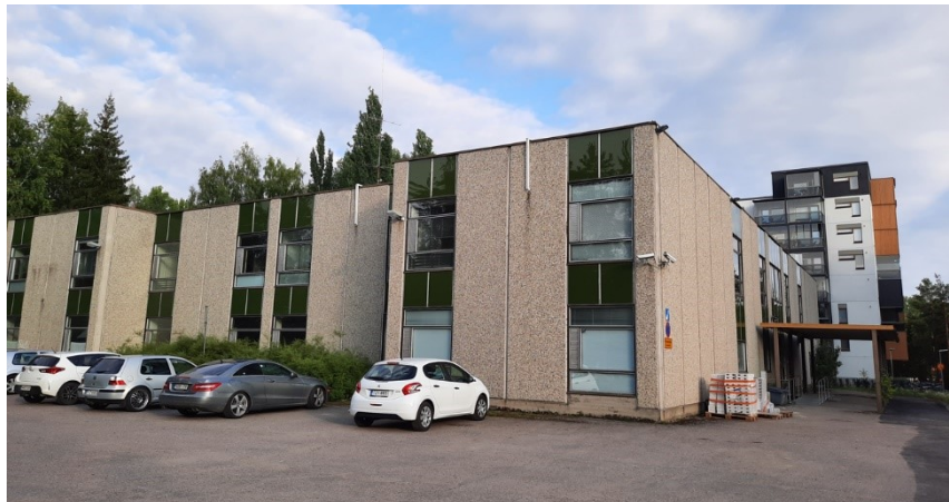
Kuva 3: Suunnittelualueelta vuonna 2021 purettu lukiorakennus. Tampereen kaupunki 2020.
