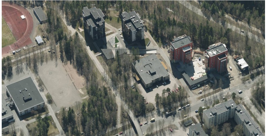
Kuva 2. Ilmakuva kohdekorttelista vuodelta 2018 ennen lukiorakennuksen (keskellä) purkua. Kuvassa näkyvät Opiskelijankatuun rajautuvan korttelin 7102 uudet kerrostalot ja kuvan vasemmassa reunassa näkyy osa Ahvenisjärven koulurakennusta. ©2018 BLOM. Kopiointi kielletty.
